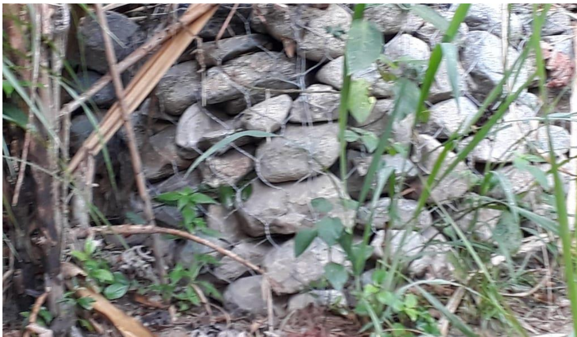
Registro fotográfico de muro de gavión construido en vereda la Selva.
