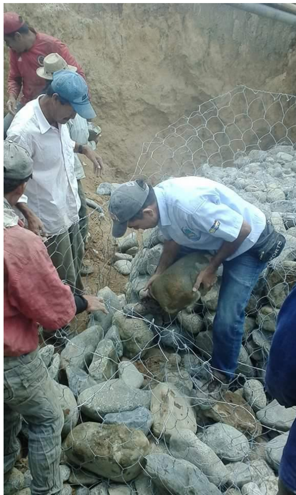
Registro fotográfico de la construcción de muro de gavión en ROVIRA vereda florida alta y san Eloy.
