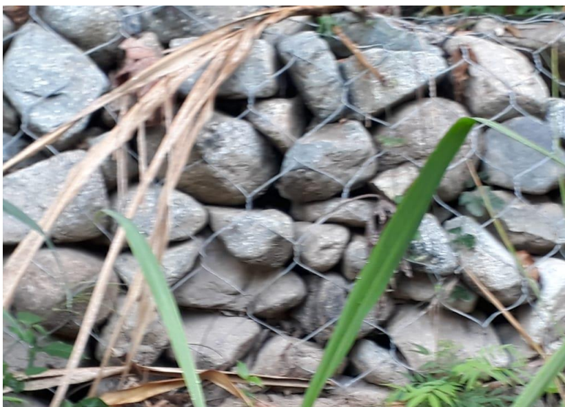
Registro fotográfico de muro de gavión construido en vereda la Selva.
